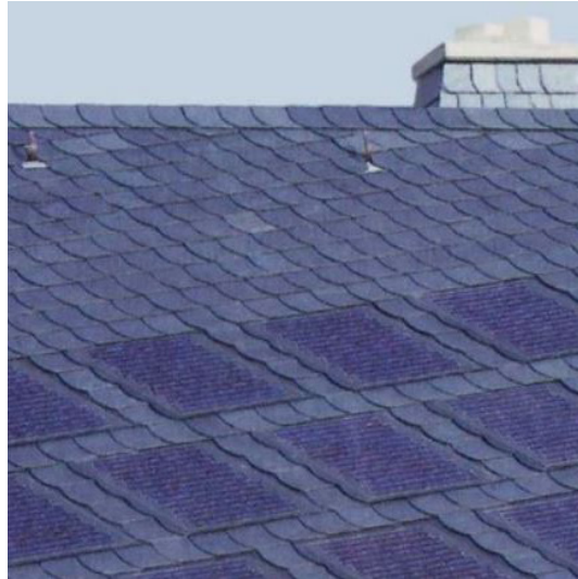
Multikristalline Solarmodule auf Schieferdach
