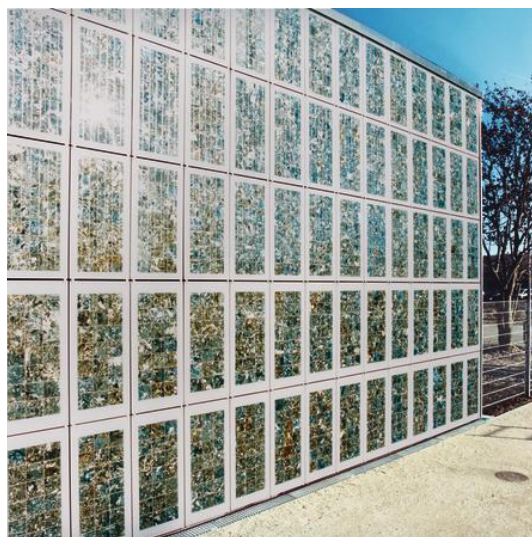
Fassadenintegrierte Solarmodule
