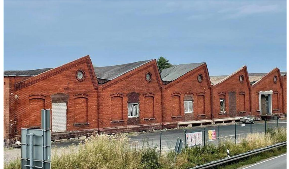
Erhalt der historischen Fassade (Anbauverbotszone)
