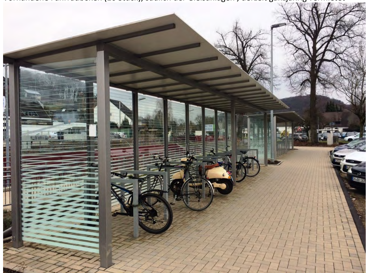
Vorhandene überdachte Fahrrad-Abstellanlage (24 Stück) ; südlich der Gleisanlagen
