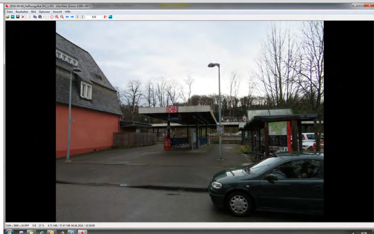
Bahnhof Hoffnungsthal (Zugang Personenunterführung/ Bike+Ride-Anlage)
